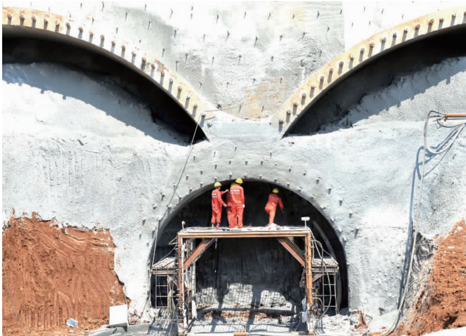
观音山隧道中导洞开始掘进 石小刚 摄
