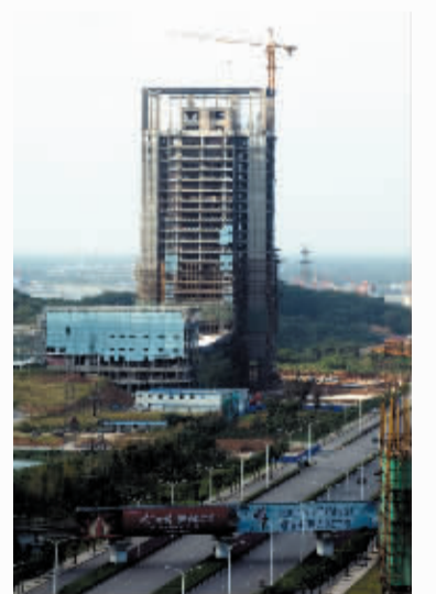
建设中的镇江新区物流大厦
