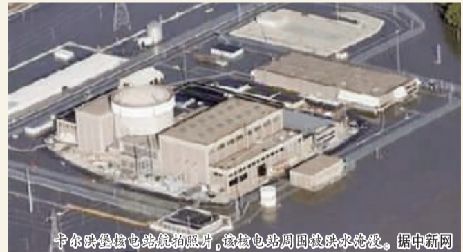
卡尔洪堡核电站航拍照片,该核电站周围被洪水淹没。据中新网
