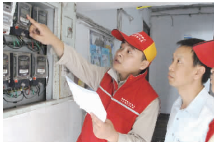
昨日,国网镇江供电公司服务队来到永安路尚友小区,将老式复费率电表更换成智能电表。据悉,我市总计160万户居民,迎峰度夏期间将对最后剩余的18000户电表进行统一更换。
