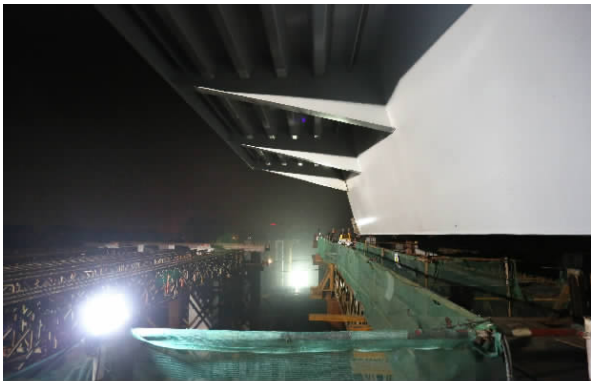
五凤口高架跨铁路工程开始顶推施工
