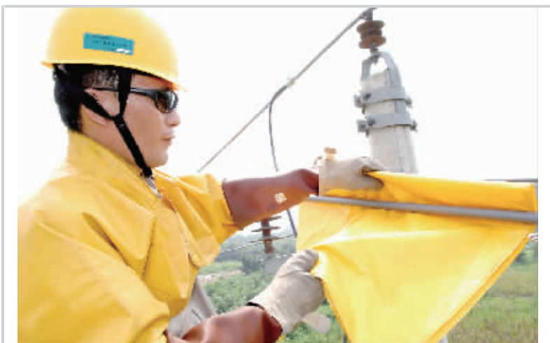
昨天,市供电公司带电作业人员冒着高温,穿戴厚重的绝缘橡皮服和手套“全副武装”进行接线引线施工作业,确保新投运的官塘垃圾中转站正常运转。 张斌 王亮 摄影报道
