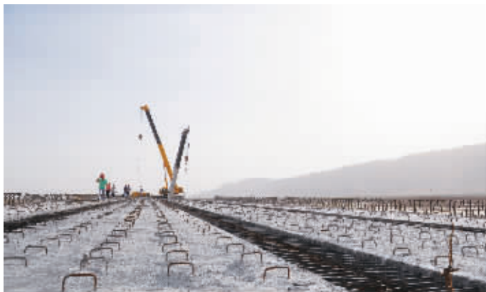
昨日,京新高速公路临河至白疙瘩(蒙甘界)段建设工程正稳步推进。该项目是国家高速公路网中第六条放射线的一部分,是北京连接内蒙古西北部、甘肃北部和新疆最为便捷的公路通道。图为工人在施工现场作业。
