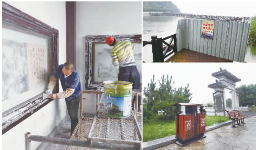
施工单位正在对北固湾东吴文化长廊进行油漆出新,广场上更新了四个垃圾桶,部分栈桥已暂时停用,将进行维修。王呈 摄
