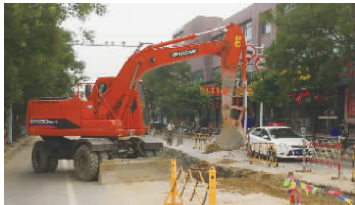
施工人员正在对塌陷路面进行维修。沈湘伟 摄
