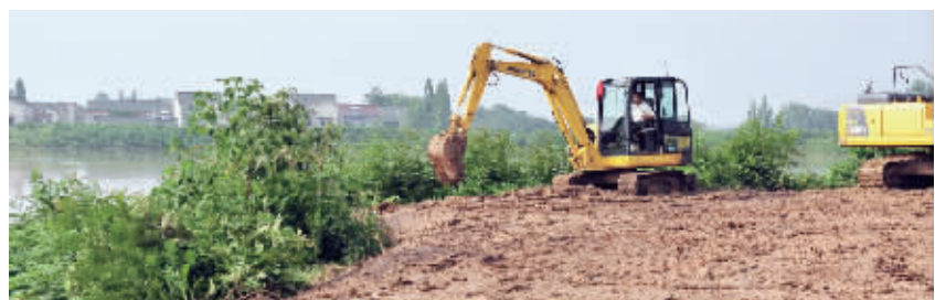
昨天下午，句容赤山湖附近的三益闸发生渗漏，当地镇村干部及水利部门技术人员对渗漏现场堵漏加固。
