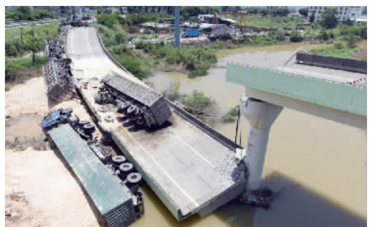
6月19日，出事的匝道和4辆满载瓷土的重载五型货车掉落地上。
